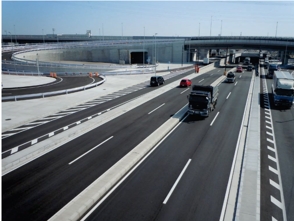
【国道129号】（新東名厚木南IC接続道路）
