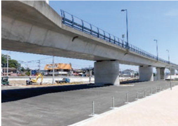
【小田原漁港の防災広場等整備】
