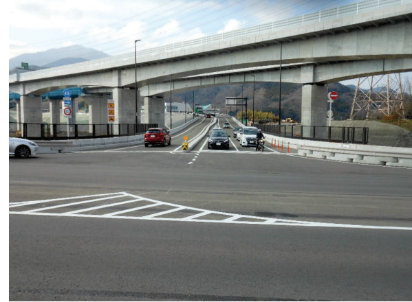
【県道603号（上粕屋厚木）】（新東名伊勢原大山IC接続道路）
