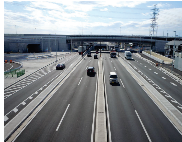
【国道129号（戸田交差点）の立体交差整備】
