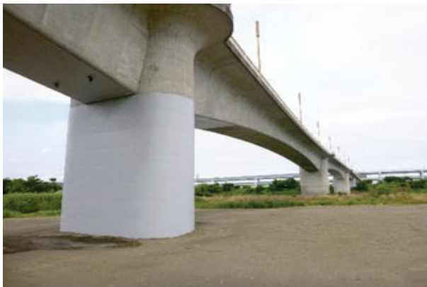
【県道47号(藤沢平塚)神川橋の耐震補強工事】
