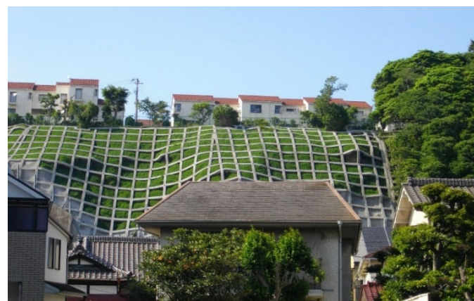
急傾斜地崩壊対策（横浜市中区内）
